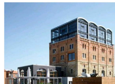
1. Bleyle TURM und Pavillon mit Gastronomie
